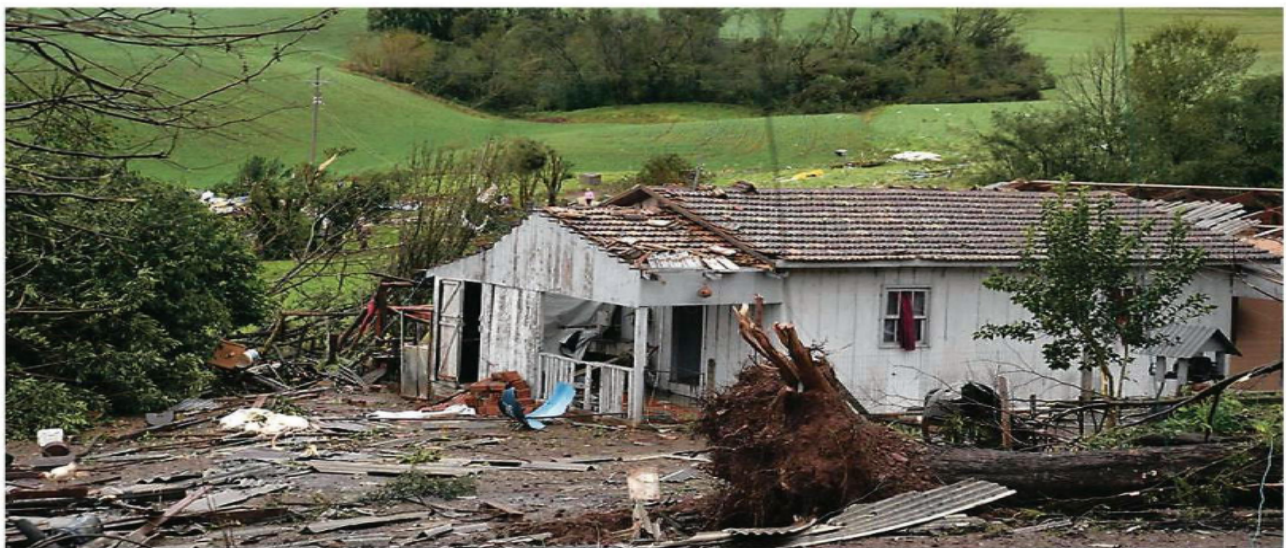
Casa é parcialmente destruída após fortes ventos em Nova Candelária, no noroeste do Rio Grande do Sul; estado registrou uma morte Divulgação/Defesa Civil do RS
