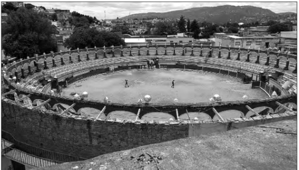
Trabajadores de la Secretaría de Infraestructura realizan labores de remodelación y mantenimiento a la plaza de toros Jorge El Ranchero Aguilar, que será una de las cuatro sedes del Campeonato Mundial de Voleibol de Playa 2023 que se realizará del 5 al 15 de octubre ■ Foto Alejandro Ancona
