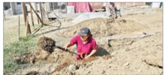
▲ Cargar tabiques o bultos de cemento no fue obstáculo para que María Santos desempeñe un oficio que ama: la albañilería. Foto Luis Castillo
